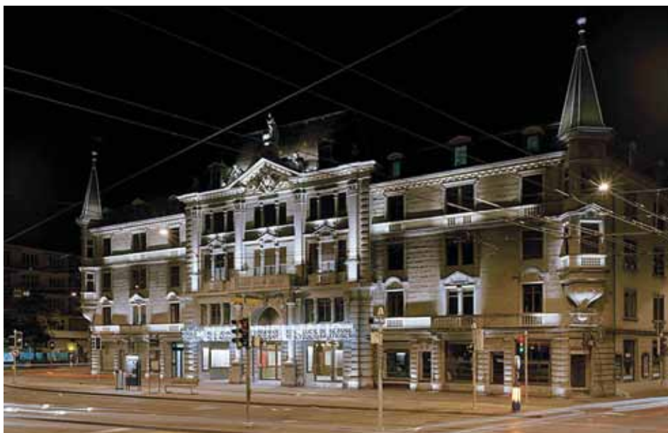
Illustration 188: Façade complète avec éclairage.
